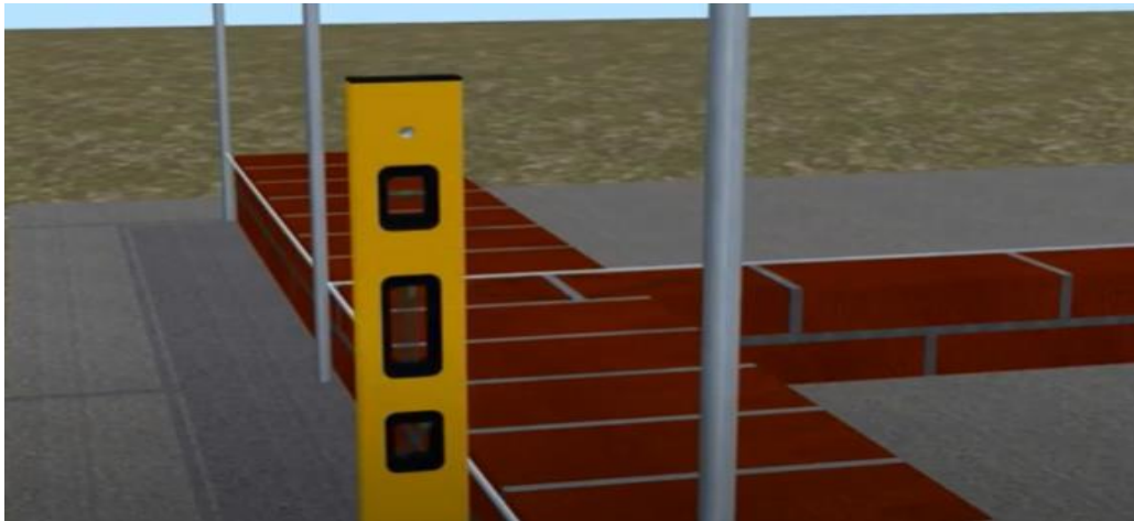
Gambar Pengecekan kerataan Vertikal pada lapisan kedua dengan waterpass
