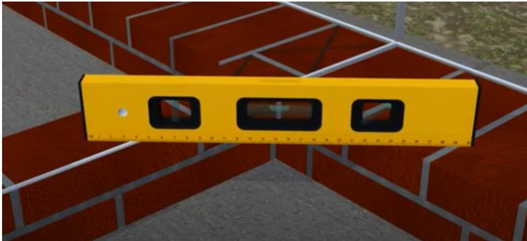
Gambar Pengecekan kerataan horizontal pada lapisan kedua dengan waterpass
