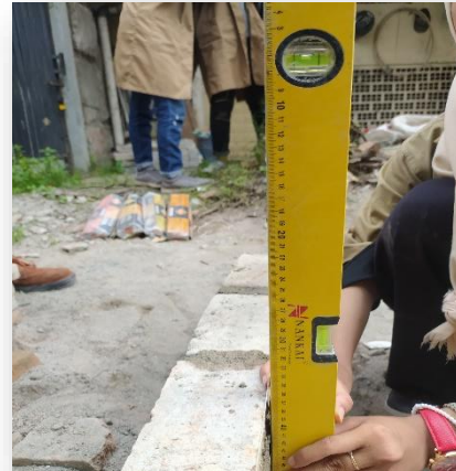
Gambar Pengecekan kerataan dinding secara vertikal dan horizontal.
