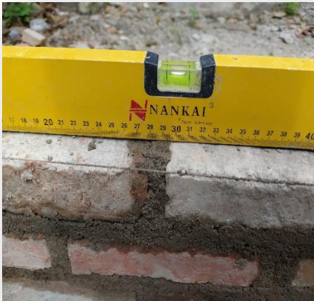
Gambar Pengecekan kerataan dinding secara vertikal dan horizontal.
