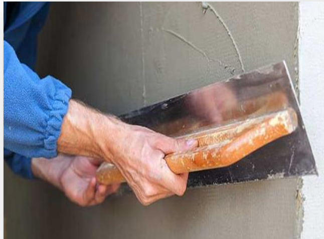
Gambar Pengacian Pada Dinding
