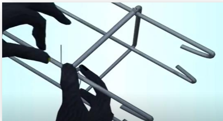
Gambar 18. Pengikatan besi tulangan dengan tulangan begeul
