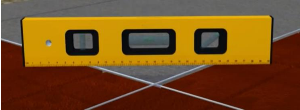
Gambar Pengecekan kerataan lapisan dengan waterpass
