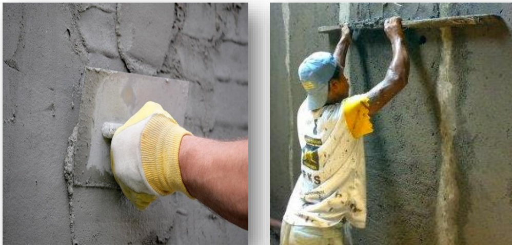
Gambar Meratakan Plesteran Pada Dinding Menggunakan Roskam
