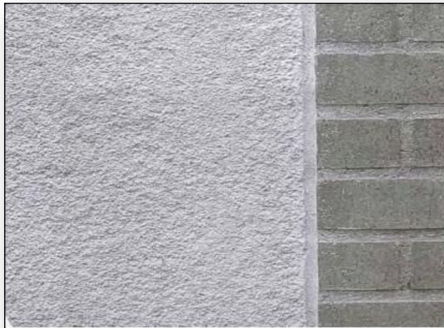
Gambar Hasil Plesteran dengan Sawutan
