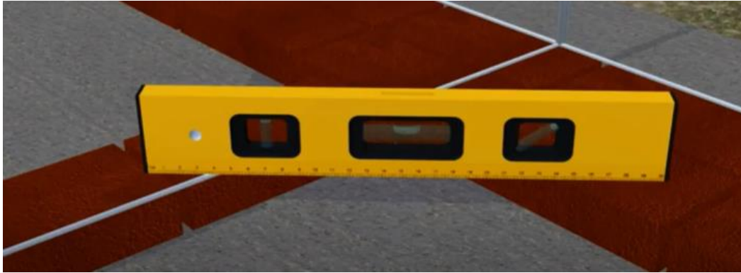
Gambar Pengecekan kerataan lapisan dengan waterpass
