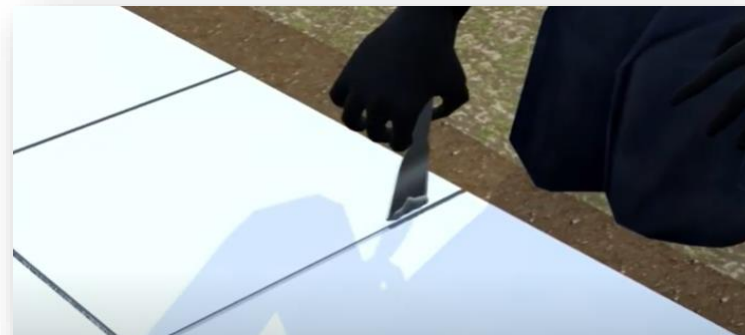
Gambar Pemberian Adukan Bubur Semen Putih Pada Celah Tegel Lantai
