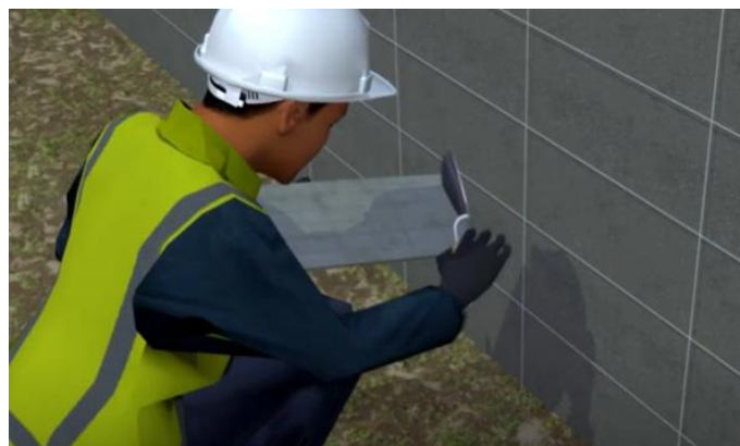
Gambar Pemberian Adukan Pada Bagian Belakang Porselin
