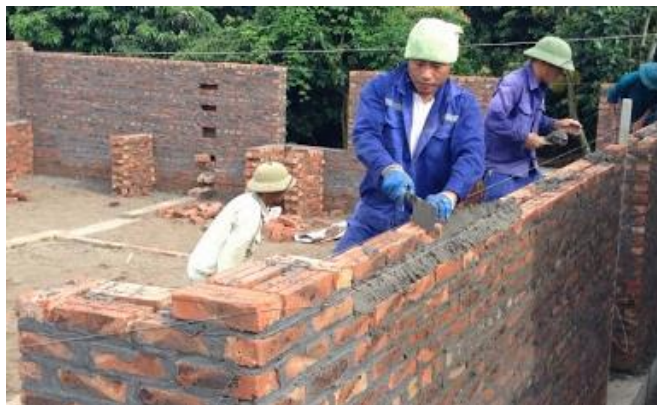
Gambar Pembuatan dinding \frac{1}{2} bata memanjang. Sumber: jaqobangunan.com
