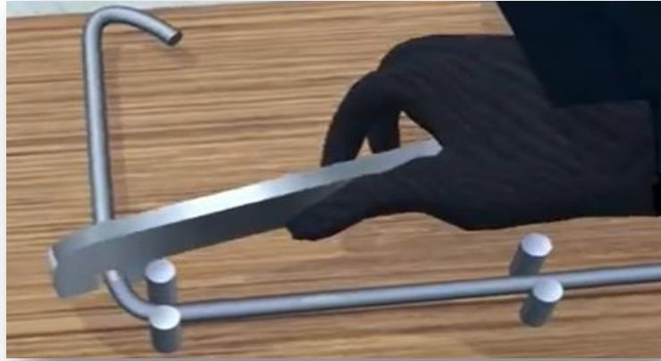
Gambar 18. Pembuatan Tulangan Begeul/Senggang
