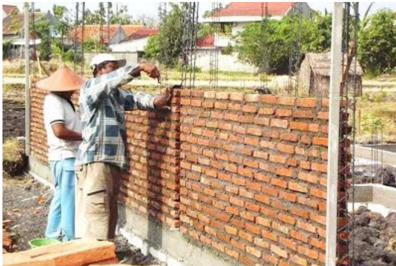
Gambar Pembuatan dinding \frac{1}{2} bata memanjang.
